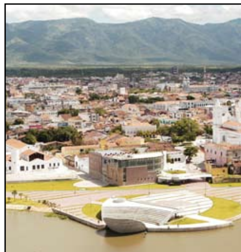
Obras de infra-estrutura estão modificando a paisagem urbana no município
